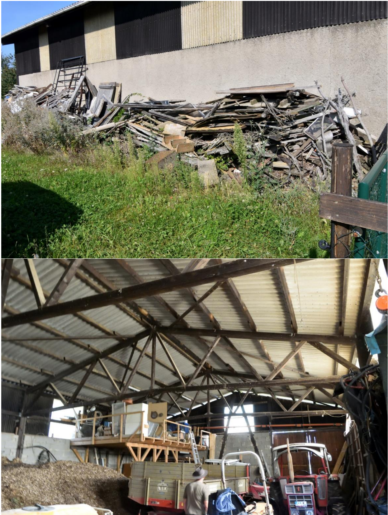
Abbildung 6: Die mittlere Scheune besitzt eine einfache Dchkonstruktion mit Wellblechdach. Hinweise auf eine Vogelbrut (z.B. Eulengewölle oder Nester) wurden nicht gefunden. Es wurden keine Kotkrümel oder Kotansammlungen auf dem Boden gefunden [Fotos: BGNatur].
