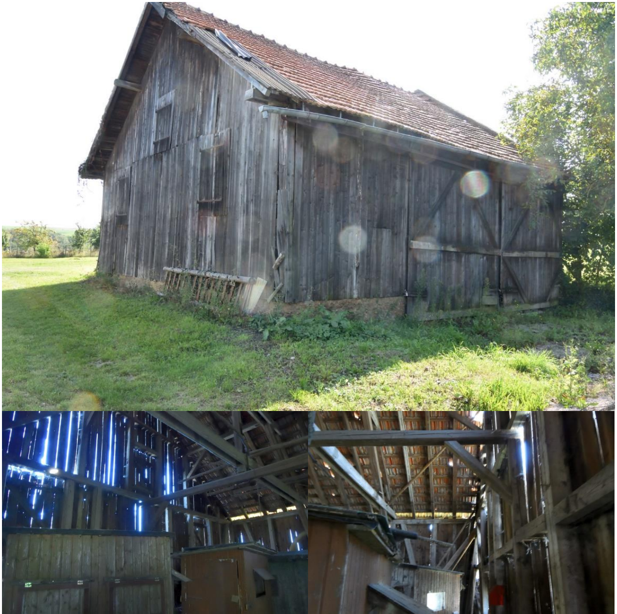
Abbildung 3: Die Holzscheune ist sehr offen gebaut, Hinweise auf eine Vogelbrut (z.B. Eulengewölle oder Nester) wurden nicht gefunden. Für Fledermäuse fehlen vor allem Spaltenquartiere. Es wurden keine Kotkrümel oder Kotansammlungen auf dem Boden gefunden [Fotos: BGNatur].
